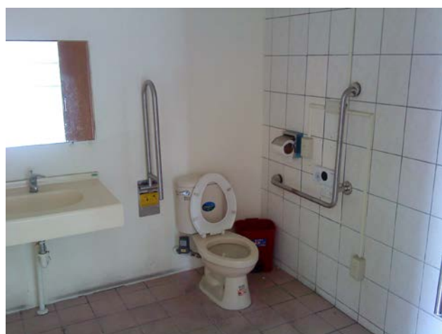
廁所無障礙設施
